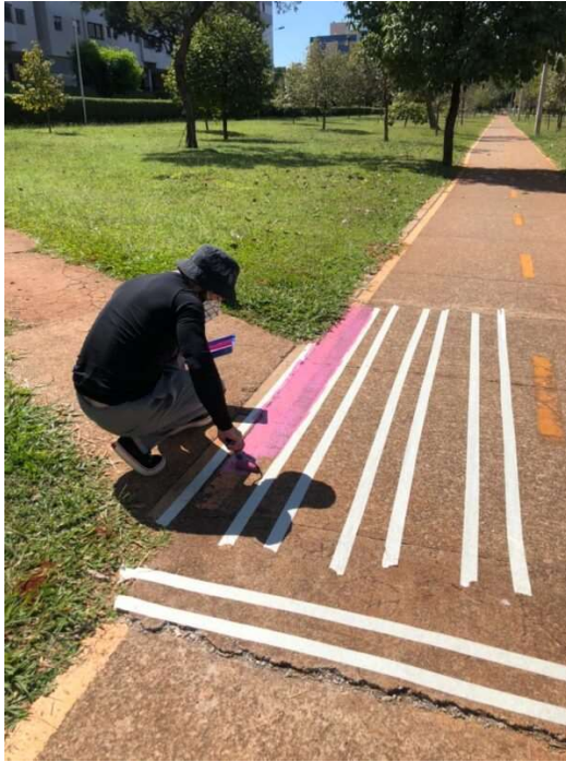
Revitalização de calçadas na SQSW 303:
