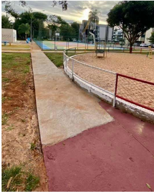
Revitalização de rampas de acessibilidade na quadra 8 da Octogonal:
